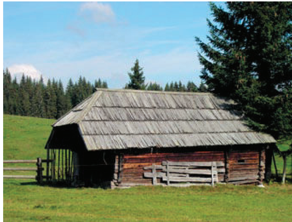
Goreljek, Knoflov stan pred začetkom obnove (foto: S. Roškar)
