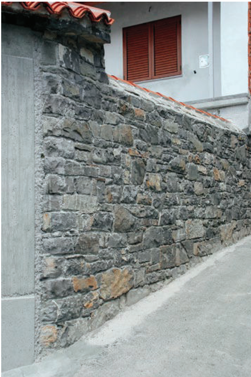
Goče, na novo pozidan dvoriščni zid domačije Goče 33 (foto: A. Ščukovt, maj 2011)
