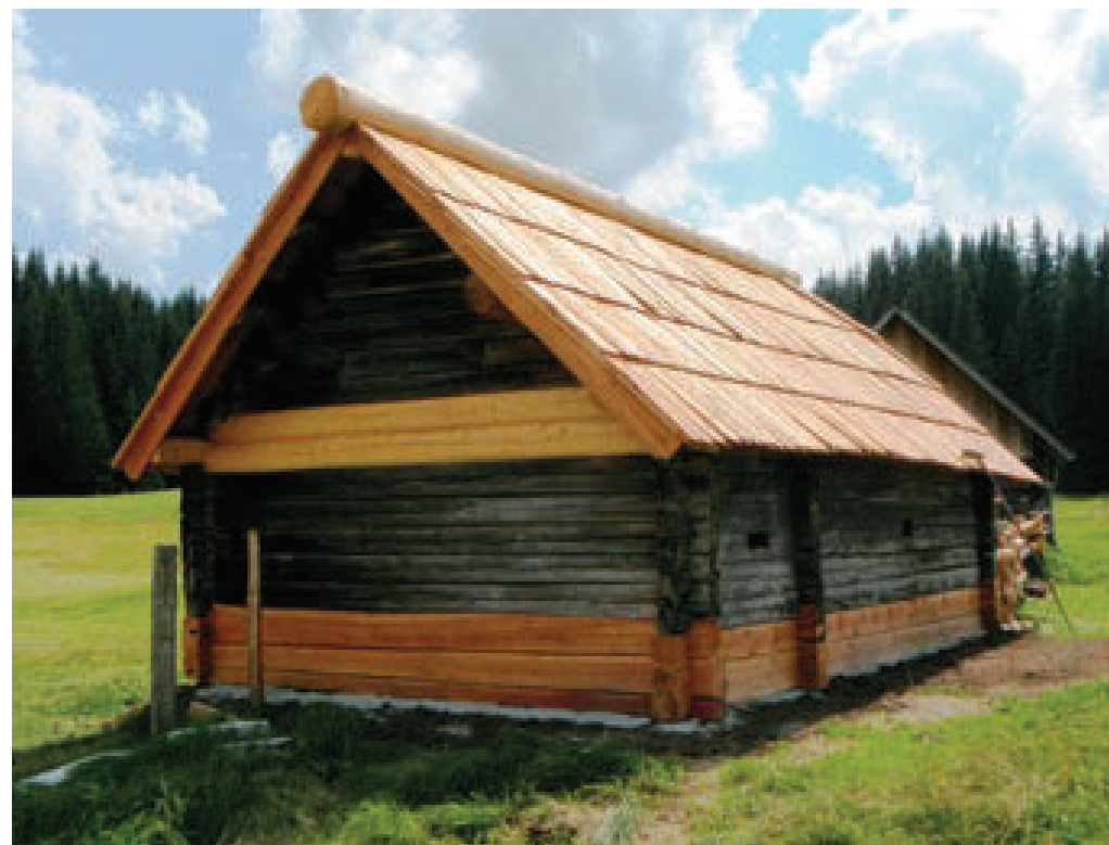
Goreljek, Knoflov stan: zadnja stran stanu po opravljenih delih (foto: S. Roškar)
